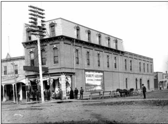
Édifice Gariépy & Lessard au coin nord-ouest de la 100th Street et l'avenue Jasper, Edmonton, 1903.
